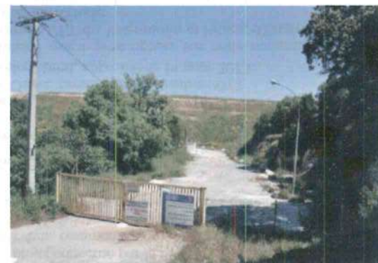
Le Centre d'Enfouissement Technique du Valentoulin réhabilité Source : SEGC Foncier – mai 2013
